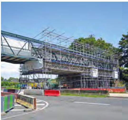
**A**u programme de cette opération située au nord de la ville : changement des mains courantes, réfection des peintures et changement des appuis. Le chantier, qui implique des échafaudages et une mise en sécurité importante de la zone, impacte la circulation avec la fermeture à la circulation de la route départementale 50 dans le sens Nandy-Sénart jusqu'à fin septembre.
